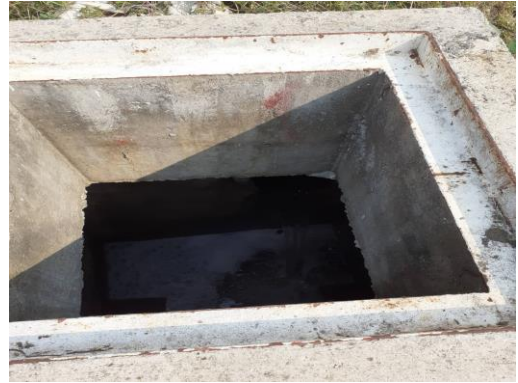
รูปที่ 7 บ่อพักน้ำทิ้งของโรงงาน
