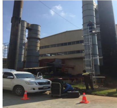
รูปที่ 4 ระบบบำบัดมลพิษทางอากาศของโรงงาน
